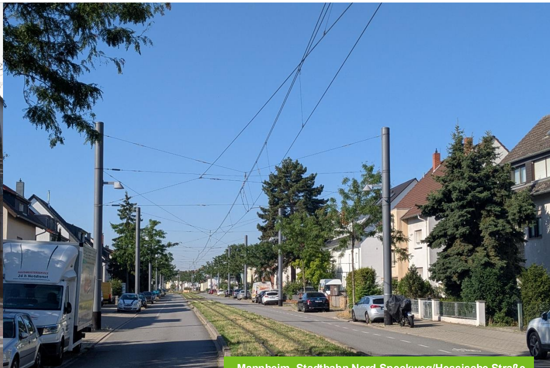
Mannheim, Stadtbahn Nord Speckweg/Hessische Straße
