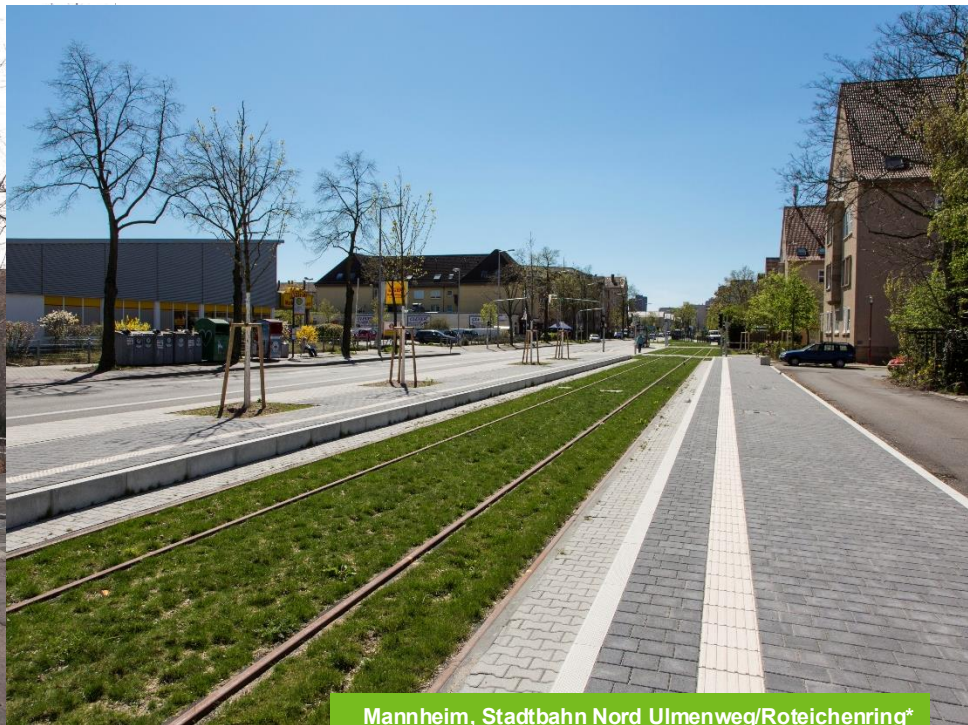
Mannheim, Stadtbahn Nord Ulmenweg/Roteichenring*
