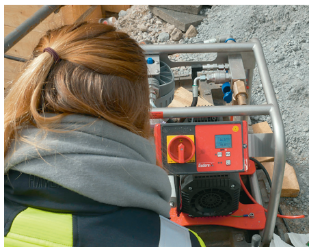
Alles dicht? Bauleiterin Ann-Sophie Arnold von Sax + Klee überwacht die Druckprüfung.
