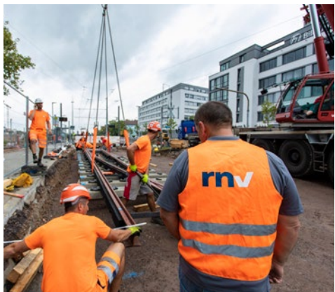
Beim Gleisbau ist Millimeterarbeit gefragt. Foto: rnv GmbH/Haubner
